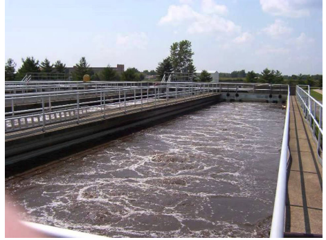
บ่อบำบัดน้ำเสีย
